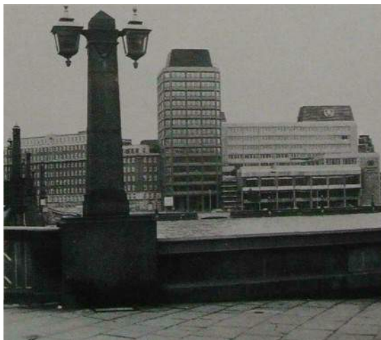
Le nouveau Siège de l'OMI sur la rive sud de la Tamise
